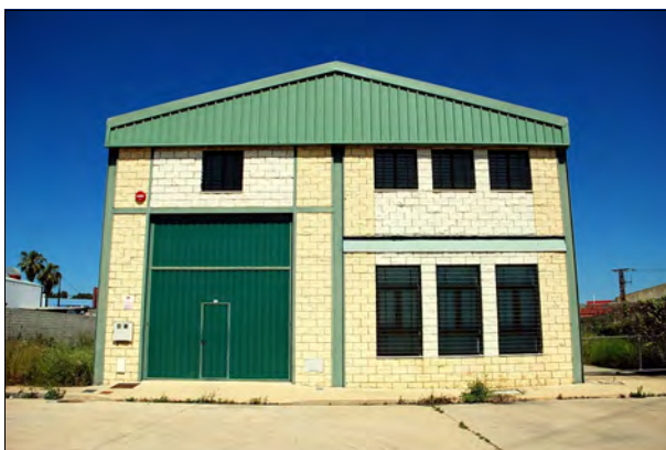
Archivos Centrales en nave en Polígono La Luz. Huelva
