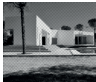
Vivienda unifamiliar Valverde del camino Arquitectos: Antonio Constantino Romero Amaro Bermejo Ponce
