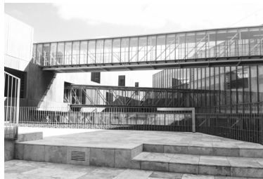
06 Páginas 14-15 Escuela Técnica Superior de Ingeniería Campus del Carmen. Huelva Arquitecto: Sebastián Cerrejón Hidalgo
