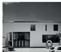
Rehabilitación de Centro Sociocultural "Casa Correos". Jabugo Arquitecto: José Antonio Pavón González
