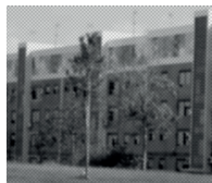
Reparación de 336 viviendas Huelva Arquitectos: M º Ángel García Font J. Antonio Ortiz Sabido
