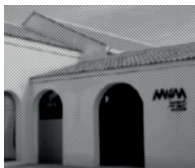
Rehabilitación de bodega para Museo del Vino Almonte Arquitecta: Natividad López Quintero
