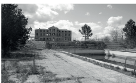
Fotografía de la demolición desde la plaza
