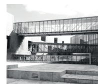
Escuela Técnica Superior de Ingeniería Campus del Carmen Huelva Arquitecto: Sebastián Cerrejón Hidalgo
