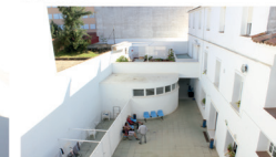
Pabellón de duchas y terraza en planta primera
