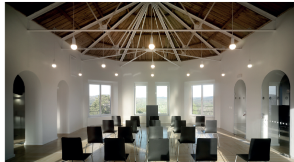
estructura robionada original recuperada (estabaculta por un forjado)
