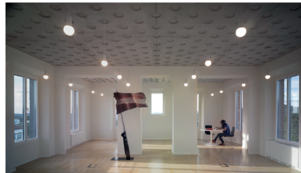
Nuevas losas texturizadas de hormigón
