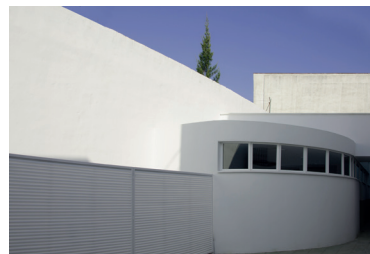
08 Páginas 19-20 Restauración, Rehabilitación e Interiores Revitalización de edificio para Centro Social C/ Cantero Cuadrado s/n. Huelva Arquitectos: Sergio Gómez Melgar María José Carrasco Conejo Henar Herrero Soriano
