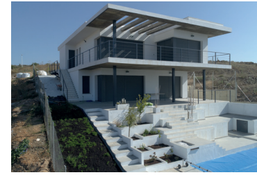
04 Páginas 11-12 Edificación de uso residencial Vivienda unifamiliar aislada Parcela r26.19 C/ Bartolomé de las Casas. Costa Esuri. Ayamonte Arquitecta: Paloma Ogáyar Lechuga
