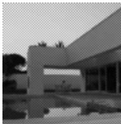
EDIFICACIÓN RESIDENCIAL La Monacilla. Aljaraque Arquitecto: Manuel Llerena Maestre
