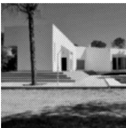
VIVIENDA UNIFAMILIAR Valverde del camino Arquitectos: Antonio Constantino Romero Amaro Bermejo Ponce
