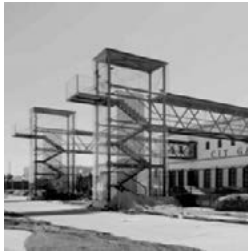
REACONDICIONAMIENTO ANTIGUA FÁBRICA DE CONSERVAS MIRABENT Isla Cristina Arquitectos: Francisco Borja Ruiz-Castizo Mirabent Concepción García Yórquez
