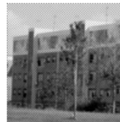
REPARACIÓN DE 336 VIVIENDAS Huelva Arquitectos: M a Ángel García Font J. Antonio Ortiz Sabido
