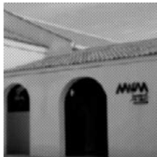
REHABILITACIÓN DE BODEGA PARA MUSEO DEL VINO Almonte Arquitecta: Natividad López Quintero
