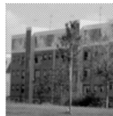
REPARACIÓN DE 336 VIVIENDAS Huelva Arquitectos: Mª Ángel García Font J. Antonio Ortiz Sabido
