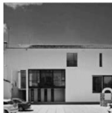
REHABILITACIÓN DE CENTRO SOCIOCULTURAL CASA CORREOS Jabugo Arquitecto: José Antonio Pavón González
