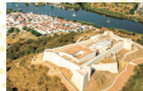
RESTAURACIÓN Y PUESTA EN VALOR DEL CASTILLO DE SAN MARCOS Sanlúcar de Guadiana
